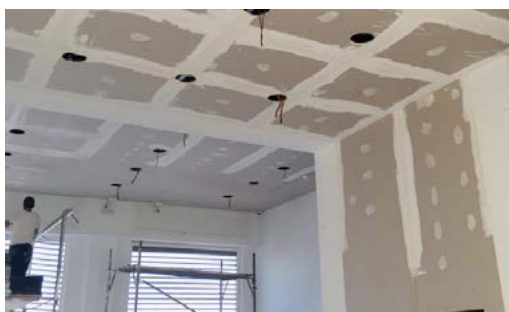
Plafond et cloison Ba 13
