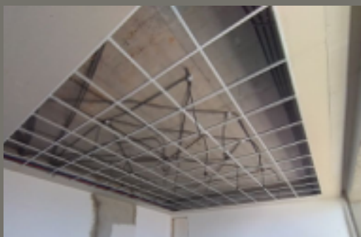
structure démontable chez école P M France
