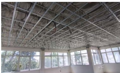
Structure plafond Ba13 M ville
